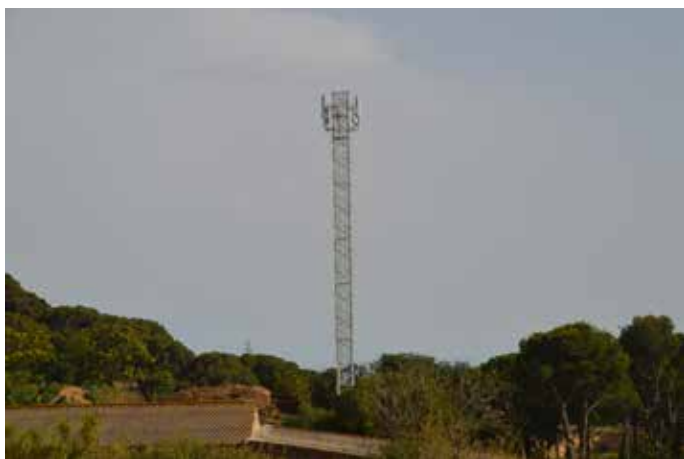
Vista de la nova torre de telecomunicacions de 40 metres instal·lada
